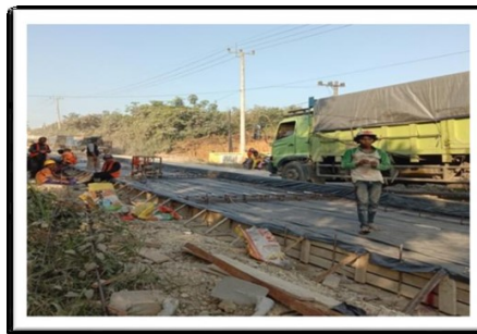
Gambar 4. 7 Pemasangan Bekisting Rigid
