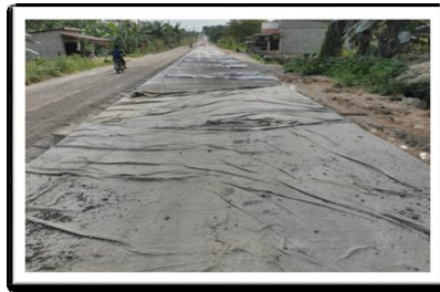
Gambar 4. 16 Pembentangan Geotextile dan Penyiraman
