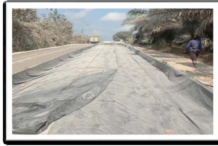
Gambar 4. 8 Pemasangan Plastic Sheet
