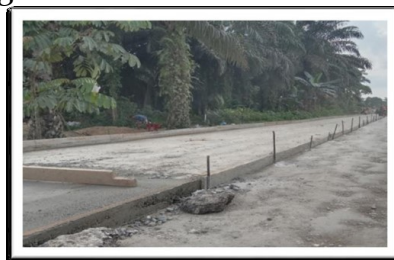
Gambar 3. Pemasangan Bekisting LC
