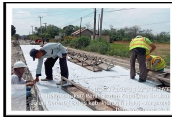
Gambar 4. 19 Opname Beton Rigid
