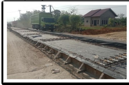
Gambar 4. 9 Pemasangan Tie Bar dan Dowel
