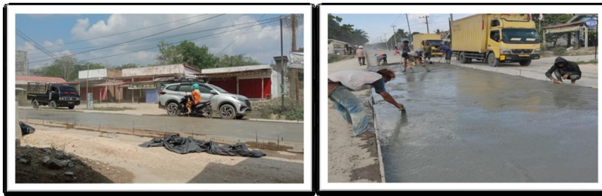
Gambar 4. 5 Penghamparan LC dan Gambar 4. 6 Perataan Permukaan LC
