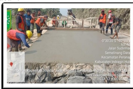
Gambar 4. 13 Proses perataan permukaan beton
