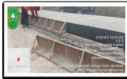
Gambar 4. 18 Pembongkaran Bekisting Rigid
