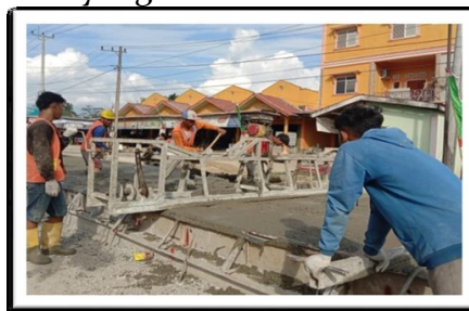
Gambar 4. 12 Proses Pemadatan Beton
