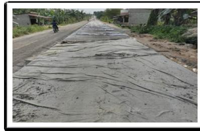
Gambar 4. 16 Pembentangan Geotextile dan Penyiraman
