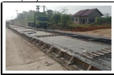
Gambar 4. 9 Pemasangan Tie Bar dan Dowel
