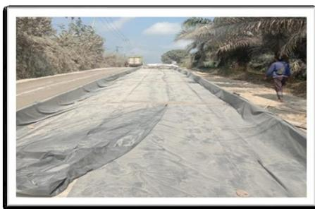
Gambar 4. 8 Pemasangan Plastic Sheet
