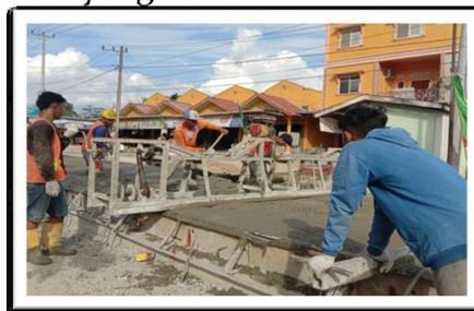
Gambar 4. 12 Proses Pemadatan Beton
