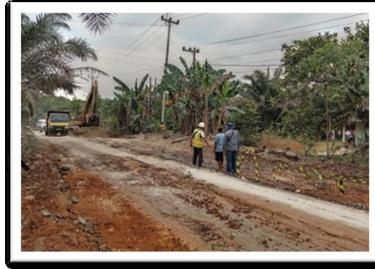
Gambar 1. Pemecahan Aspal Lama
