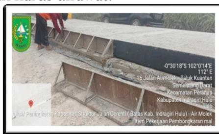
Gambar 4. 18 Pembongkaran Bekisting Rigid
