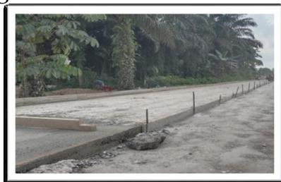
Gambar 3. Pemasangan Bekisting LC
