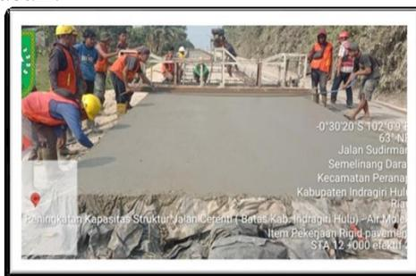
Gambar 4. 13 Proses perataan permukaan beton
