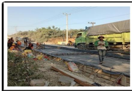
Gambar 4. 7 Pemasangan Bekisting Rigid
