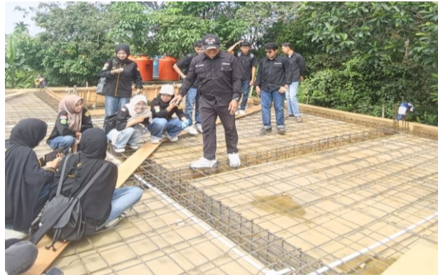
Gambar 1. Observasi dan Pemeriksaan Pembesian Sebelum Pengecoran
