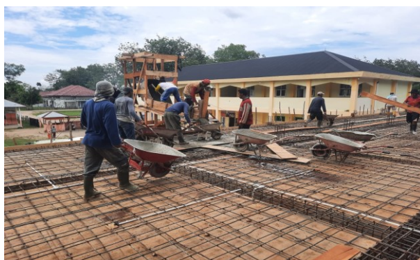
Gambar 2. Proses Pelaksanaan Pengecoran Beton Pelat Lantai
